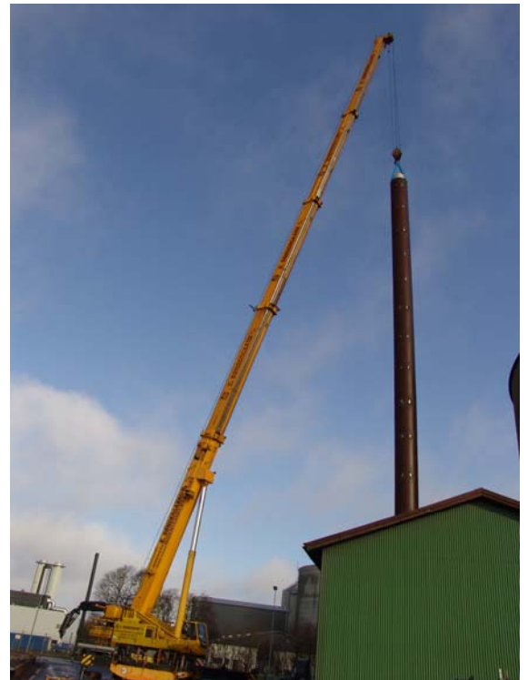
Her er skorstenen ved at være på plads
