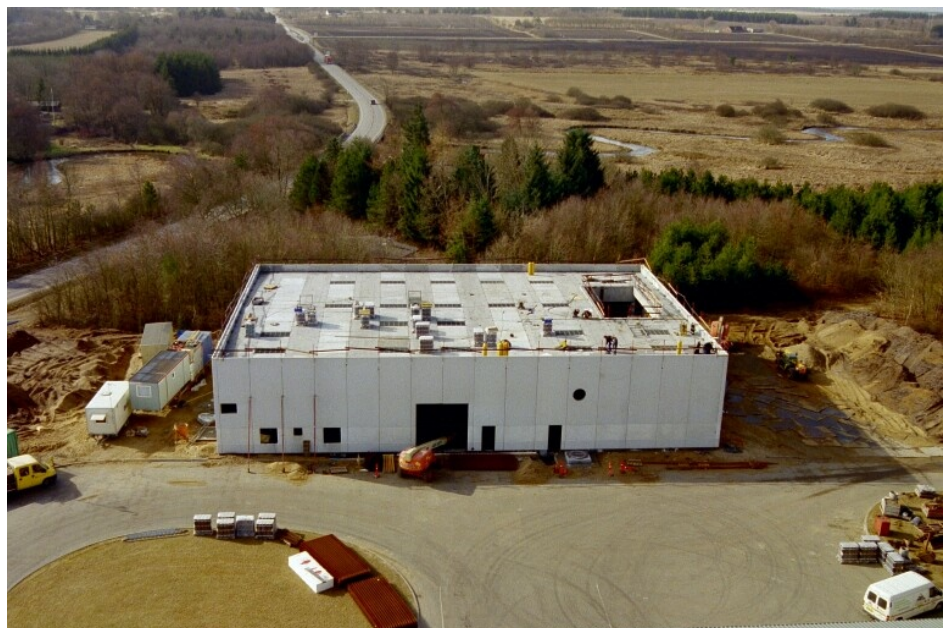
Den nye proteinfabrik under opførelse april 2004
